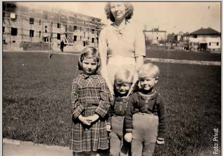
Mutter Wiesner mit Kindern und die im Bau befindlichen Polenblöcke.
